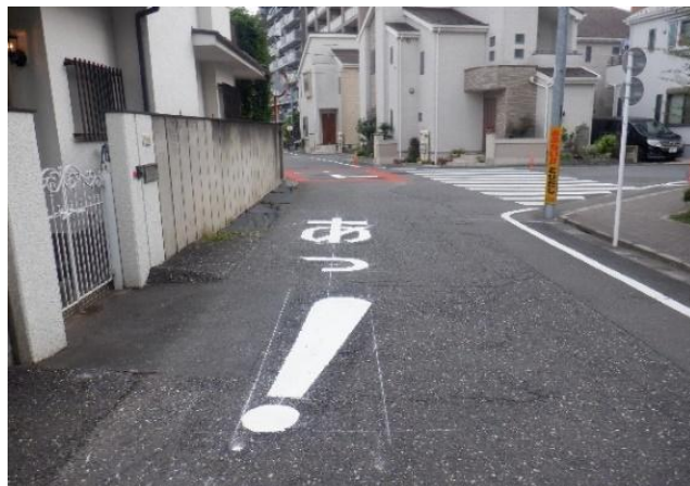
見通しの悪い生活道路での注意喚起用法定外路面標示「あっ！」の施工状況 (東大和市、東大和警察署)
