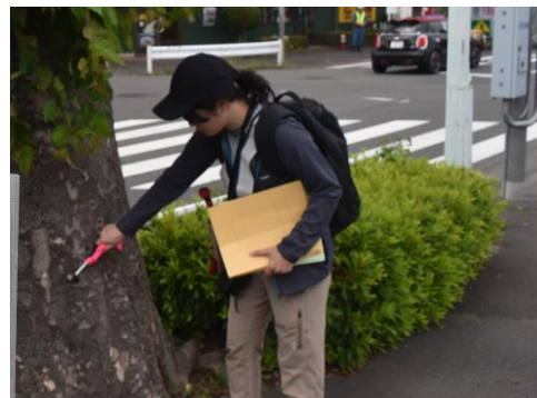
打診による腐朽の確認
