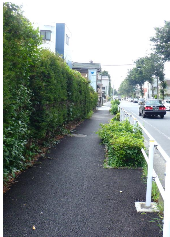
有効幅員 2m未満の歩道 (3号線：けやき通り)
