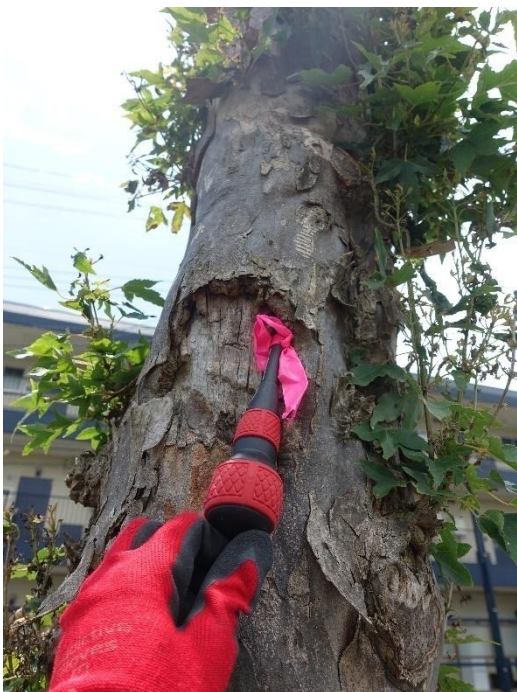
幹が腐朽し鋼棒が刺さるトウカエデ (7号線)
