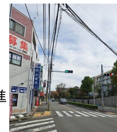
▲無電柱化を事業中の路線 (立3・4・17号桜街道線)
