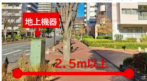
▲地上機器と歩道幅員（市道第 815 号線）
