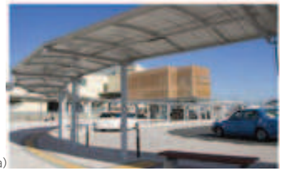
参考イメージ：通路の屋根（新所原駅北口駅前広場） a)
