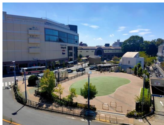
狛江駅北口駅前広場
