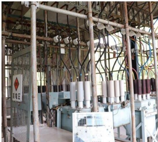
変電所から工場に供給していた電気がショートを起こしたときに、自動的に回路を遮断して安全を守るための装置です。
