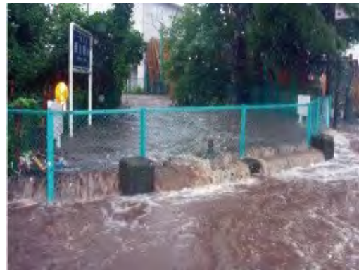
平成28年8月台風9号 奈良橋川の氾濫
