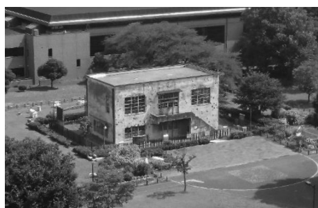
市指定文化財 旧日立航空機(株)変電所
