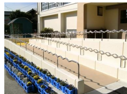
段差解消スロープの設置イメージ
