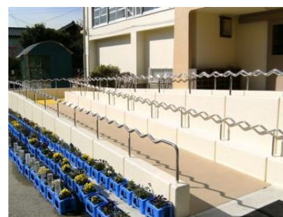
段差解消スロープの設置イメージ
