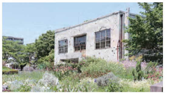
▲旧日立航空機株式会社変電所
