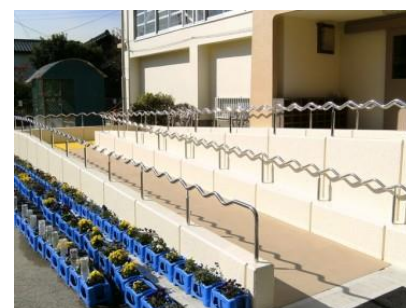
段差解消スロープの設置イメージ
