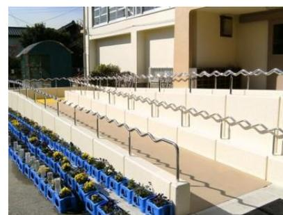
段差解消スロープの設置イメージ
