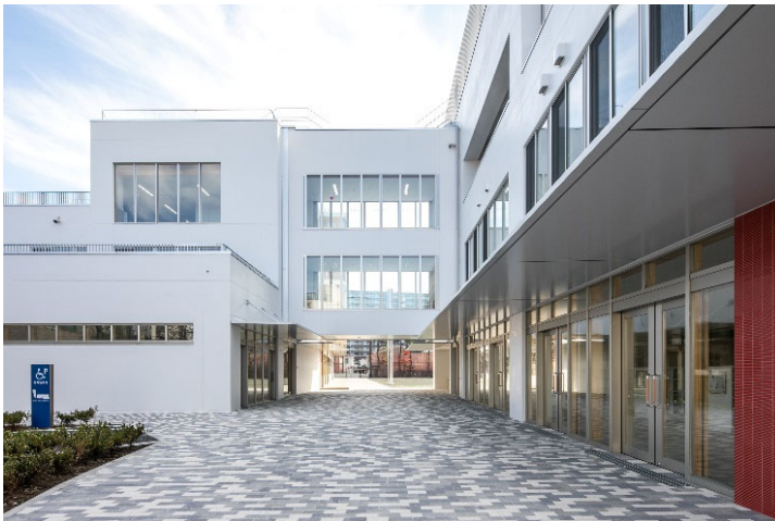
車いす使用者等が利用する駐車場から玄関までバリアフリー化された敷地内通路のイメージ
