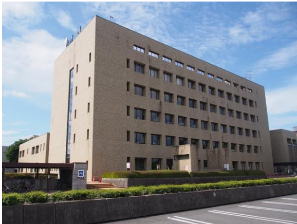
東大和市役所 本庁舎
