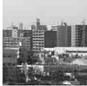
マンション建設が進む桜が丘地域
