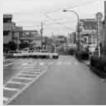
工事中の都市計画道路
