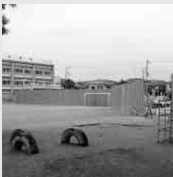
校舎増築工事が進む二小
