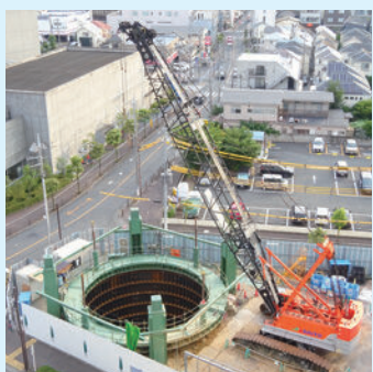
空堀川上流雨水幹線工事
