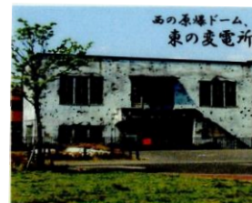
旧日立航空機株式会社変電所 (戦災建造物)
