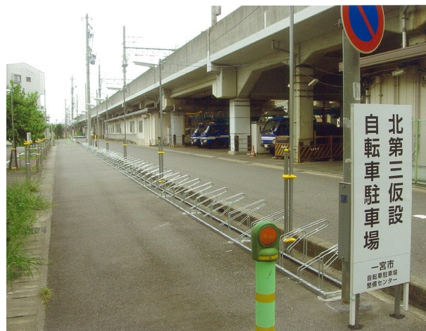
④歩道上の駐車場
