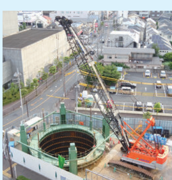
空堀川上流雨水幹線工事
