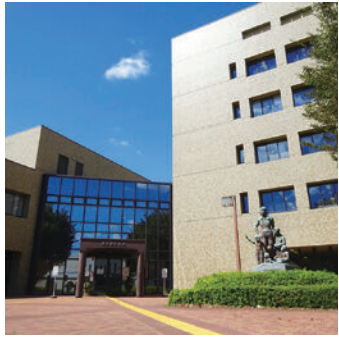
東大和市役所
