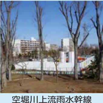
空堀川上流雨水幹線立坑設置工事
