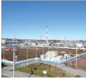
(仮称)東京街道運動広場整備工事
