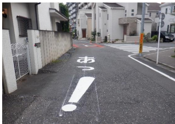
見通しの悪い生活道路での注意喚起用路面標示「あっ！」の施工状況
