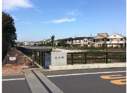
整備された都市計画河川空堀川(高木橋)
