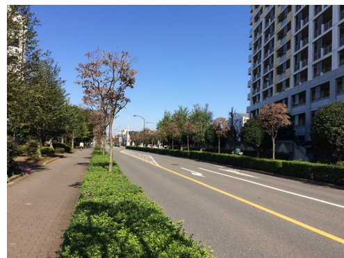
都市計画道路(立3・4・26号線)として整備された市道第5号線<ハミングロード>(向原団地)
