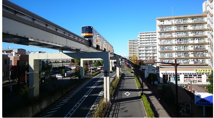
立3・3・30号線と多摩都市モノレール (玉川上水駅から北を臨む)
