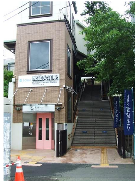
バリアフリー化された武蔵大和駅
