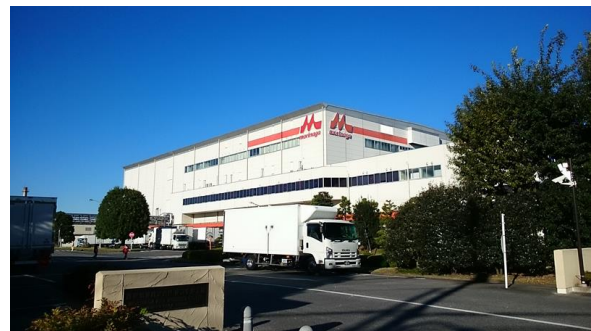
安定した操業が望まれる大規模工場
