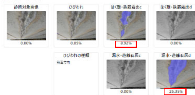
漏水・遊離石灰の「d」と自動で評価
