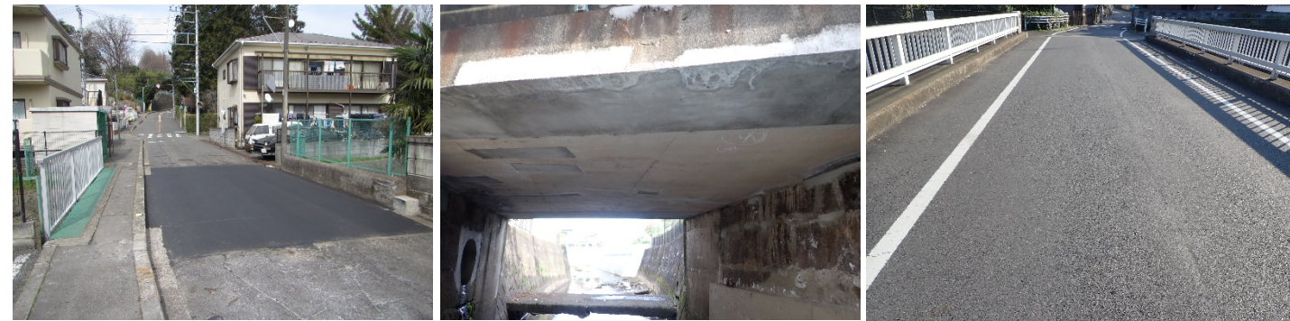
奈良橋（舗装、フェンス）
