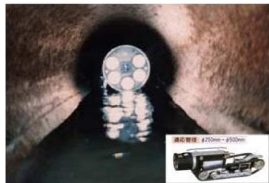
図 3-219 TVカメラによる点検・調査
