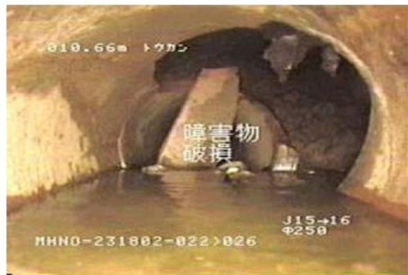
図 3-217 破損した管渠
