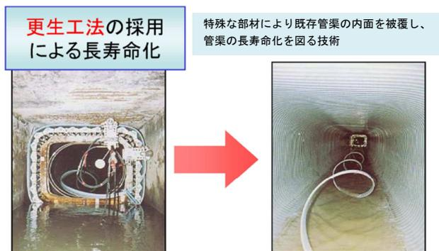
図 3-218 更生工法の採用による長寿命化
