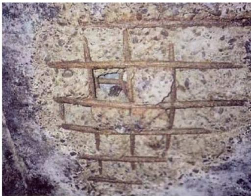
図 3-216 コンクリートが腐食し鉄筋が露出した管渠
