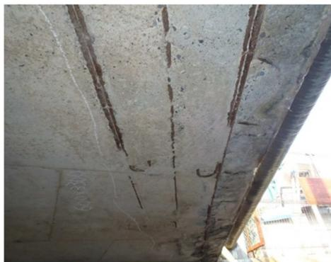
図 3-211 鉄筋が露出・腐食した橋
