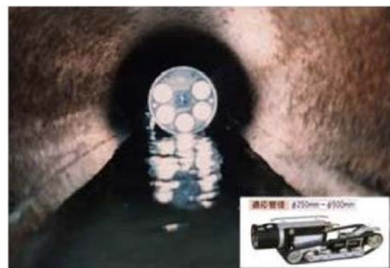
図 3-219 TVカメラによる点検・調査
