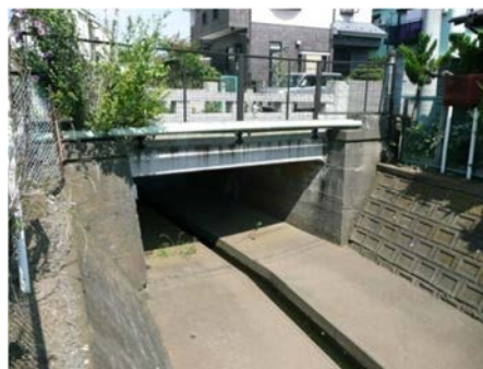
図 3-207 昭和 6 年に建設した古い橋 （清水 1 丁目「本村橋」）
