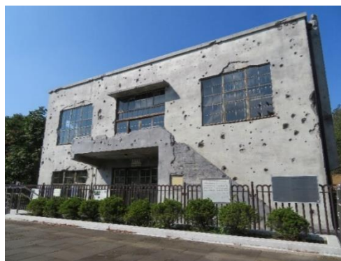
旧日立航空機株式会社変電所
