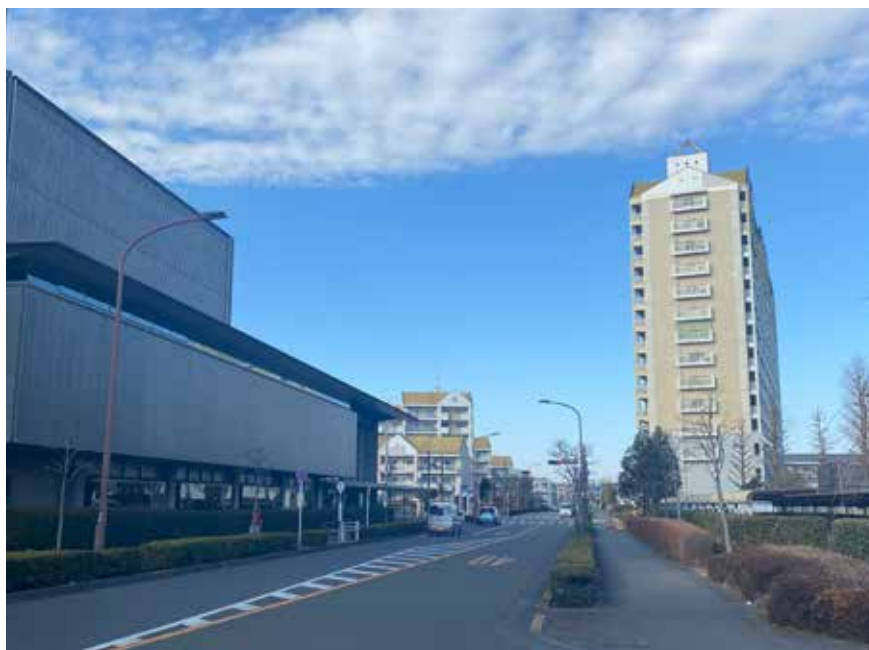
市民会館（ハミングホール）と 都市計画道路3・4・26号東大和清水線（ハミングロード）
