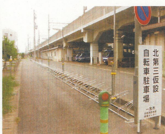
④歩道上の駐車場
