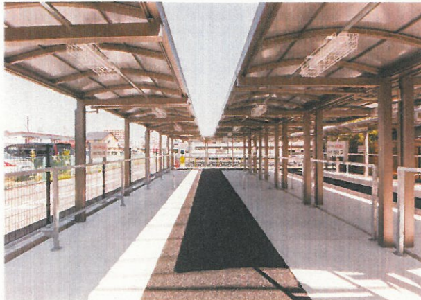
①屋根付き駐車場（ラック無し）
