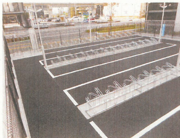
③屋根無し駐車場（ラック付き）
