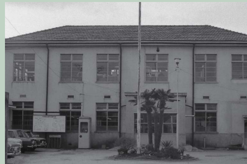
旧東大和市役所
