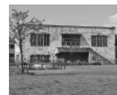
旧日立航空機株式会社変電所
