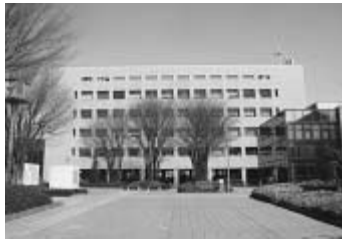
耐震補強工事を行う市役所本庁舎
