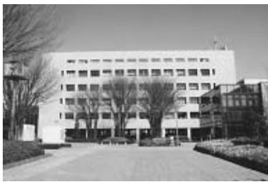
耐震補強工事を行う市役所本庁舎
