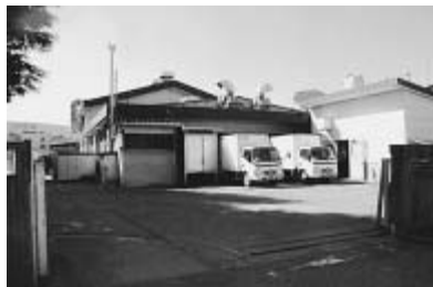
現在稼働中の第二給食センター
