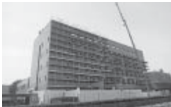
▲工事中的本庁舎（5月3日撮影）
