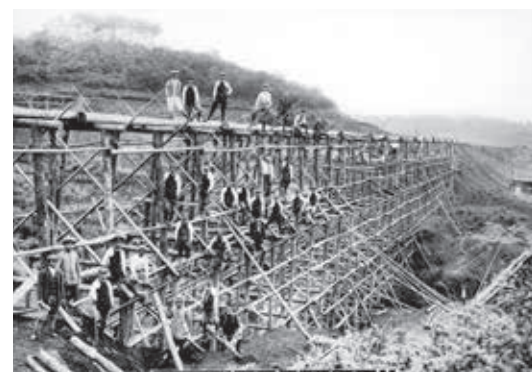
▲下えん堤の建設工事の様子
