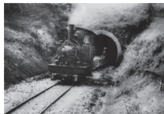
▲資材運搬のために敷設された軽便鉄道
