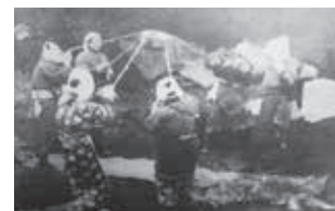
▲人力による土固めの様子。重いコンクリートのかたまり（タコ）を、力を合わせて宙に浮かせ、地面に落とすことで土を固めました。写真のように、この作業は「女衆」と呼ばれる女性が行うことが多かったそうです。
