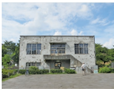
▲旧日立航空機株式会社変電所
