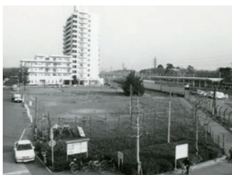
▲整備工事前の玉川上水駅前広場予定地(平成元年1月15日号市報より)
