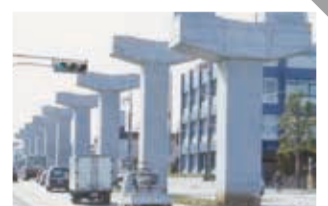
建設中の様子・上北台団地東 交差点付近 (平成3年撮影)
