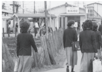
▲駅名変更前(「青梅橋駅」) の「東大和市駅」・東やまと市 報(昭和54年3月15日号)より
