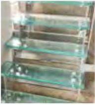
内部の階段は、外壁と同じく機銃掃射による損傷を受けていました。その様子や木製手すりを残すため、ガラス製階段を設置しました。
