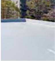
前回の防水改修工事から20年以上が経過し、複数箇所にて雨漏りをしていました。今回の工事では、古い防水シートを全て剥がし、新たに防水塗料を塗りました。
