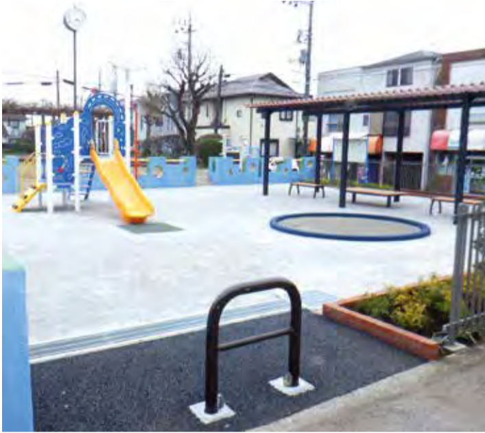
▲一部改修工事が完了した高木公園
