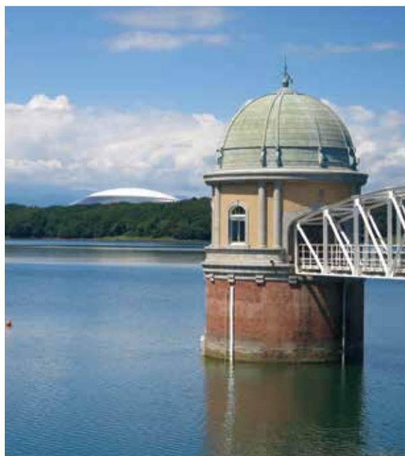
▶多摩湖の取水塔
