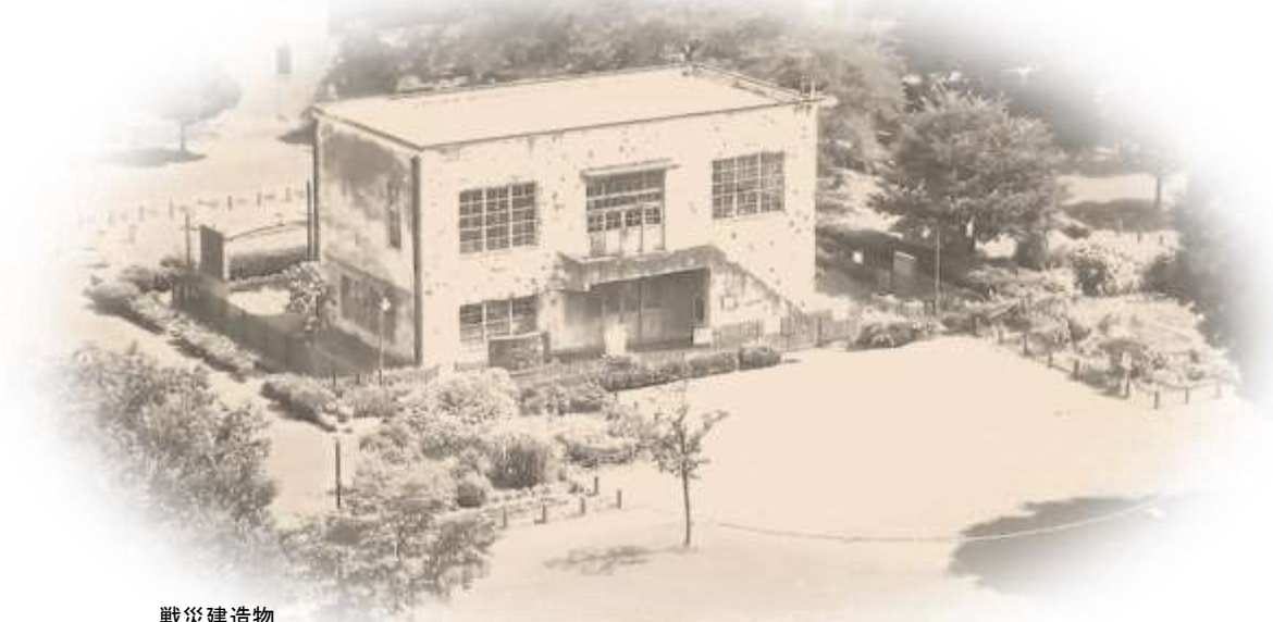
戦災建造物 旧日立航空機株式会社変電所
