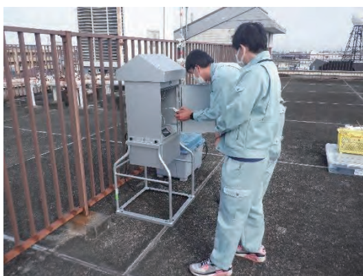
上北台市民センター 屋上
