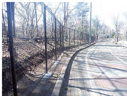
狭山緑地 外柵改修工事
