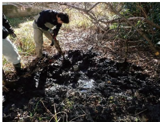
候補地点の仮掘削
