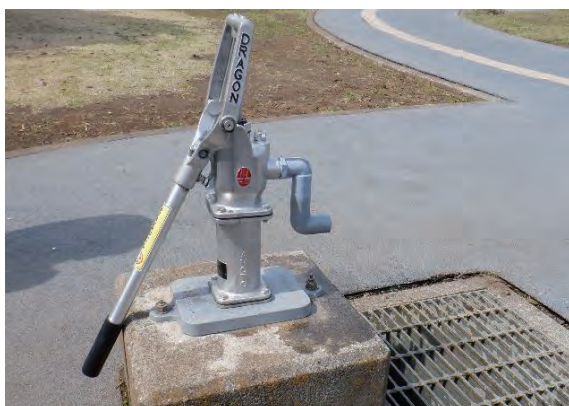
立野中央公園 「天水槽（雨水貯留槽）」
