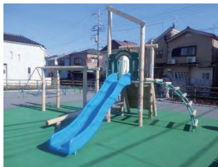
末広公園 改修工事
