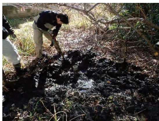
候補地点の仮掘削
